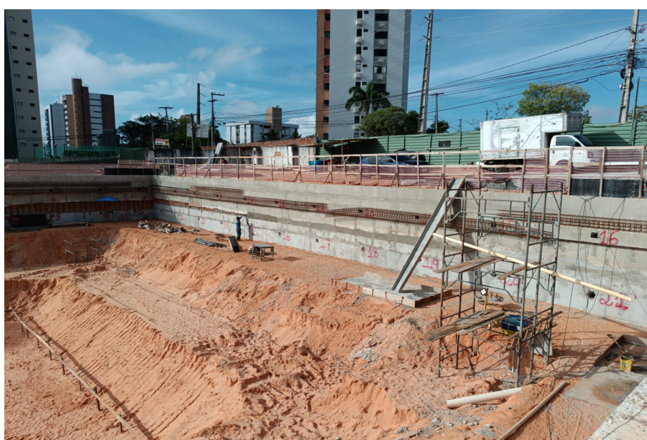
Figura 6: contenção, segunda linha de tirantes já preparada para a execução.
