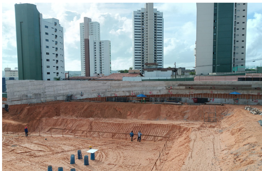
Figura 7: Parte de um dos dois muros de contenção em L.
