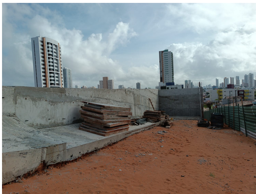
Figura 8: Parte de um dos dois muros de contenção em L.
