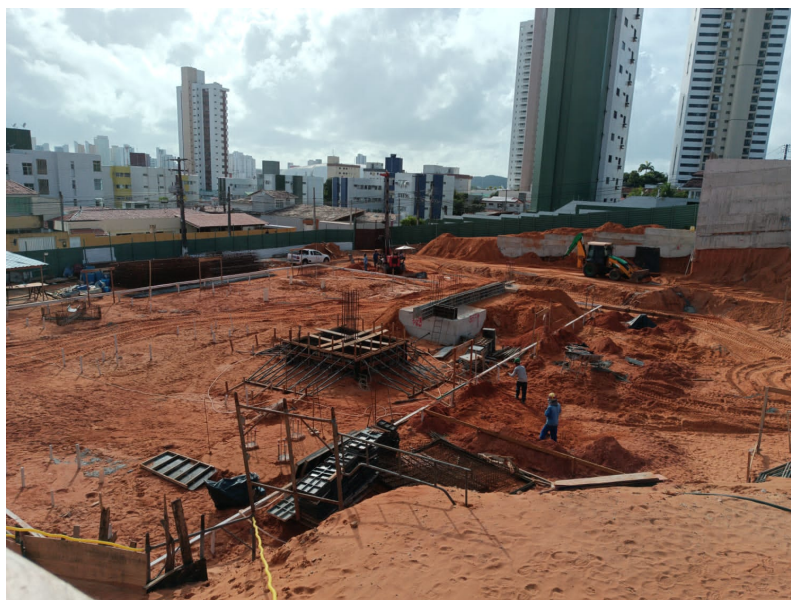
Figura 9: Concretagem dos blocos de coroamento.
