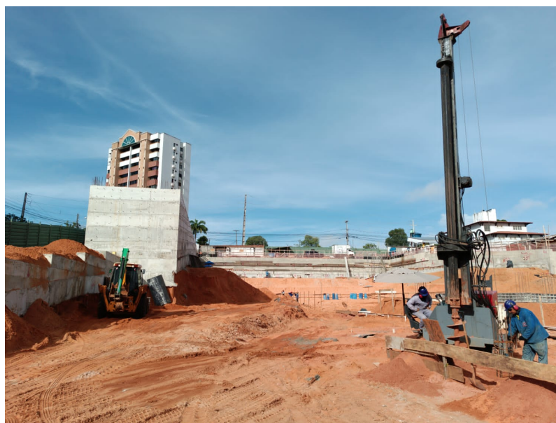
Figura 10: perfuração das estacas da fundação.
