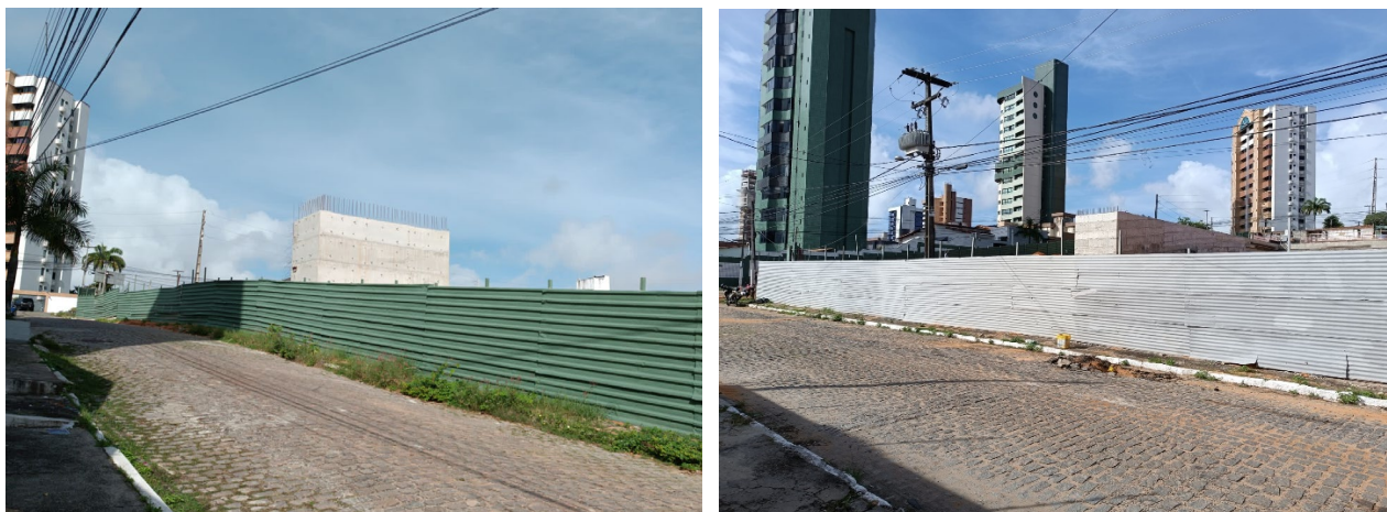
Figuras 2 e 3: Proteção em tapume metálico.
