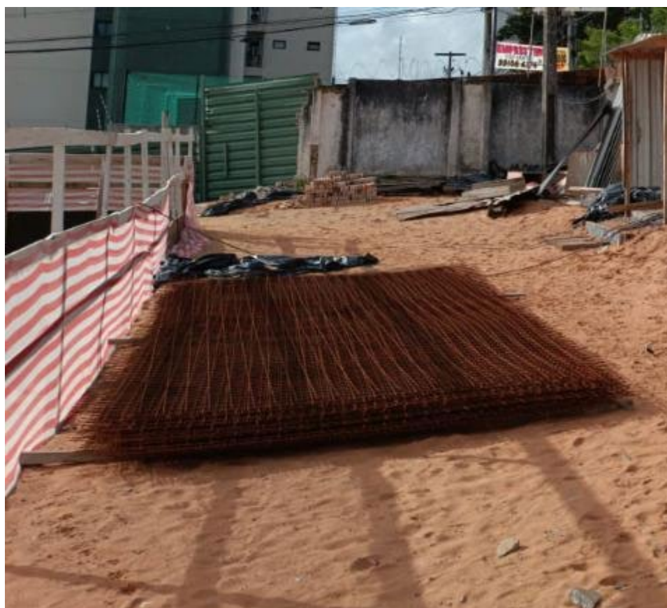
Figura 1: guarda corpo de proteção perimetral.
