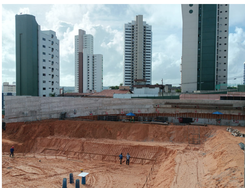
Figura 4: escavação, carga e transporte de solo.
