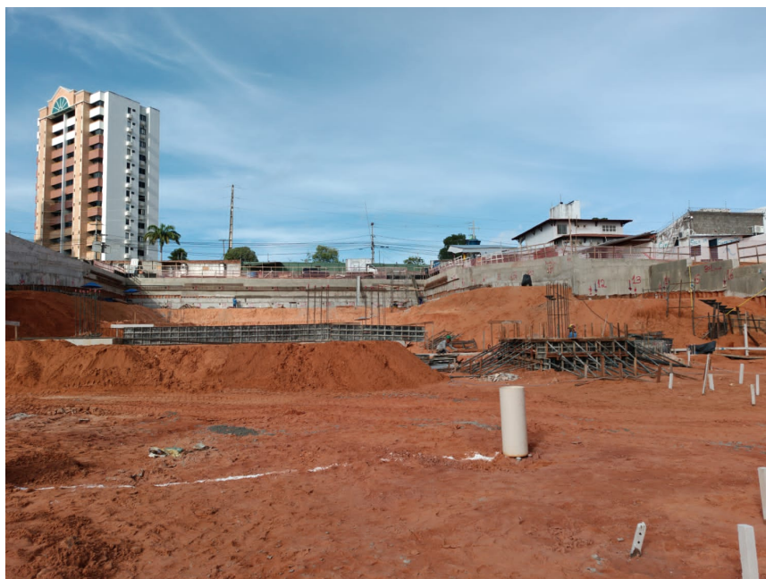
Figura 5: escavação e carga de solo.
